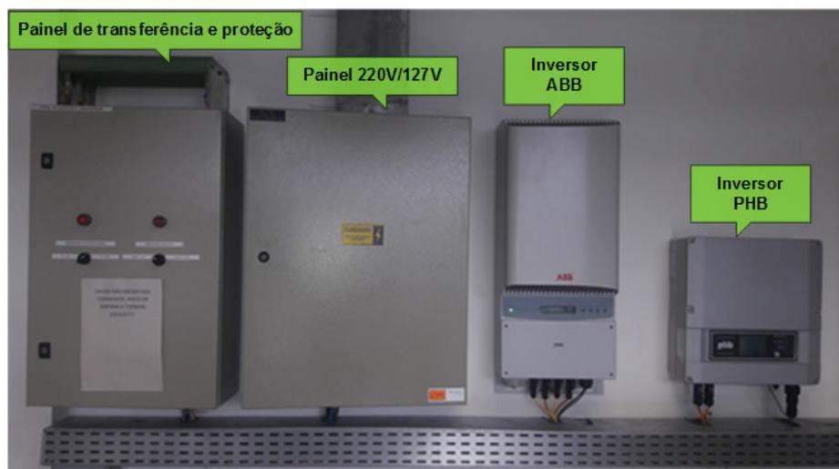
**Figura 3.4:** Instalação de inversores fotovoltaicos comerciais e quadro de transferência/proteção.
